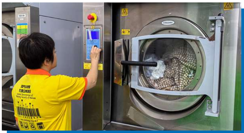
●圖二：心悅洗衣社會企業採用 ECOLAB 自動化洗衣物料系統，有效地節省洗衣過程中的物料、水、電力及時間
